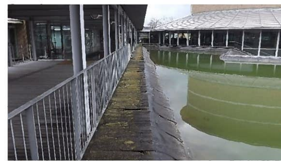
会館周辺ウッドデッキ・外構の改修
