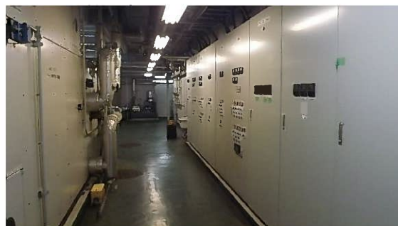
電気設備・空調設備の改修
